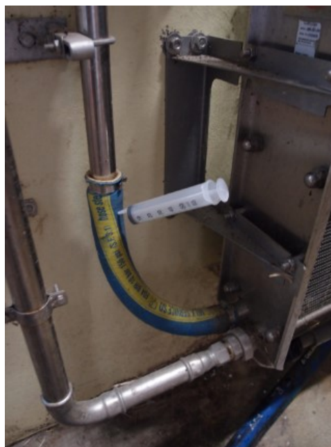
Udtagning af mælkeprøve før og efter pladekøleren for at tjekke om den er utæt. Foto: SEGES
